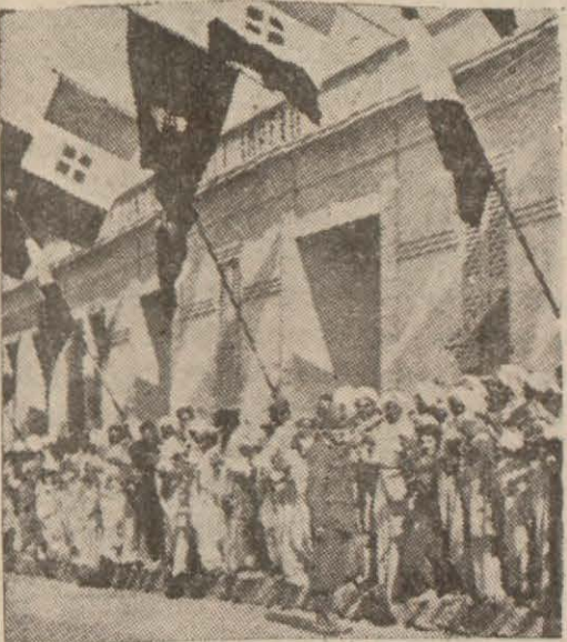
Tobruda (Libya) Musoliniyi alkışlamak için yollara dökülen Araplar.
